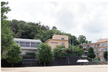
工事が行われる長尾台小学校
