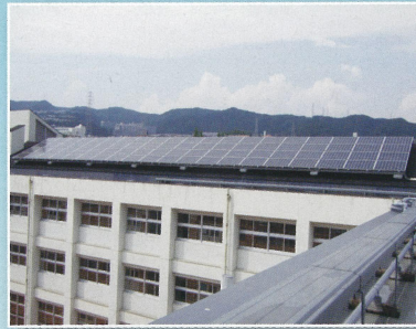
学校園発電所 (山手台中学校)
