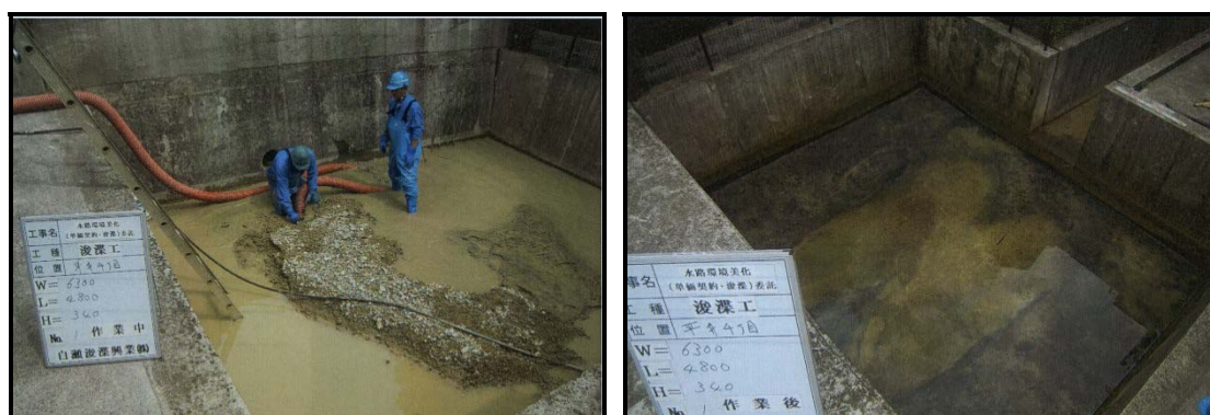
図-14 調整池の土砂浚渫(左:作業中、右:作業後)
