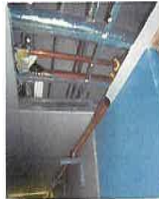
トレーニング室 漏水修繕
