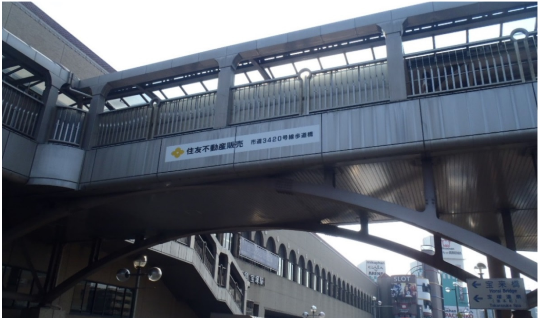
住友不動産販売 逆瀬川 市道 3303 号線歩道橋
