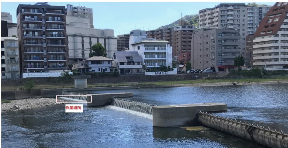
観光ダム（奥から、右岸・中央・左岸）
