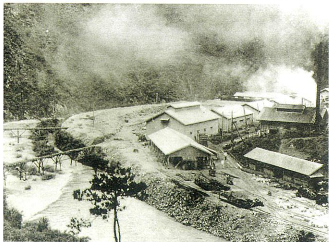
◆千疋水源地堰提工事中の発電所 大正4(1915)年8月
