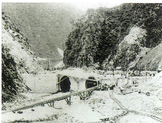
◆千疋水源地堰提工事中の発電所 大正4(1915)年11月
