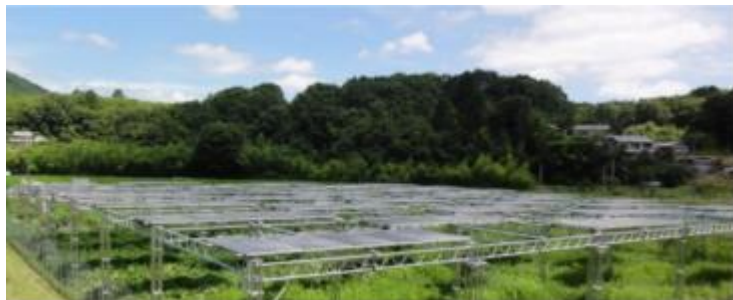
発電施設の外観
