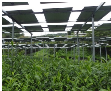
設置された太陽光パネル
