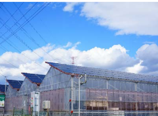
発電施設の外観
