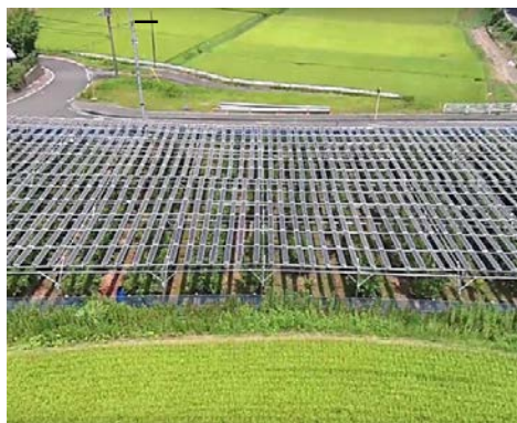
発電施設の外観
