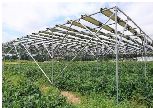
発電設備の外観
