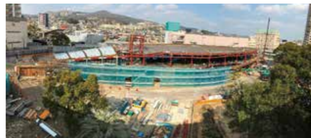
建設中の文化芸術センター (手塚治虫記念館屋上から、3月末撮影)
