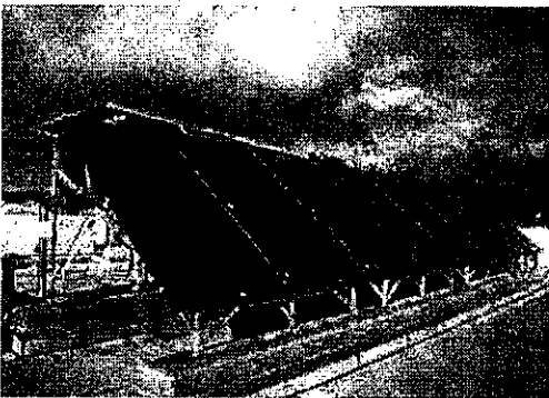
消防署西河原分署に設置した太陽熱温水器
