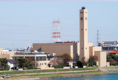
老朽化が進み、建て替えを予定しているクリーンセンター
