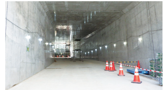
荒地西山線トンネル内部
