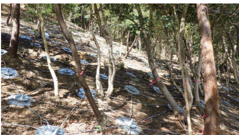
土砂災害対策工事
