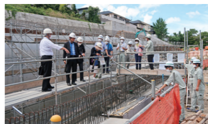
工事中の都市計画道路荒地西山線の現地調査
