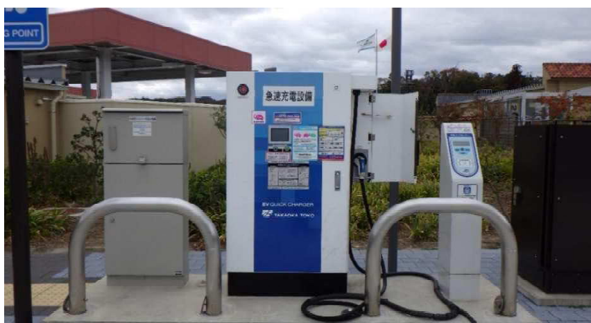
ウ コネクター（充電用ケーブルを電気自動車等に接続するためのもの）
