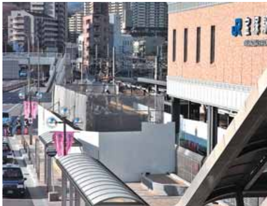
JR宝塚駅前に設置工事中の公衆便所
