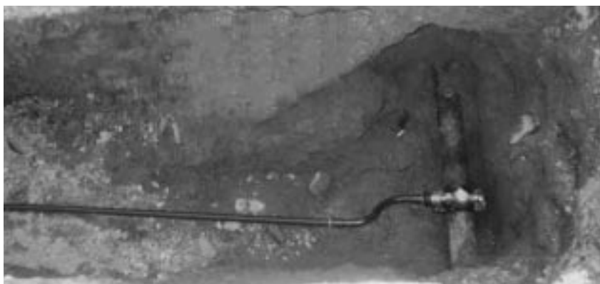
塩化ビニール製給水管に取替
