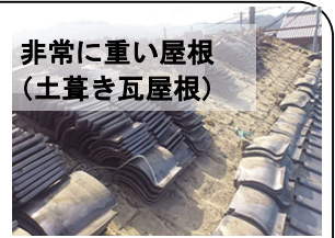
非常に重い屋根(土葺き瓦屋根)
