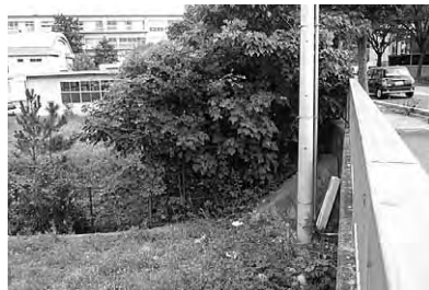
斜面の利用で階段設置可能
