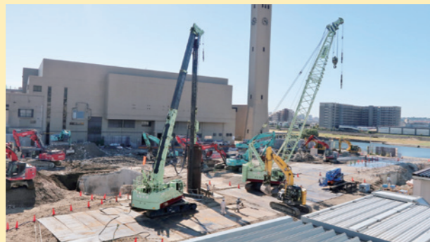
現地視察 令和5年度に実施した事業のうち、新ごみ処理施設の工事進捗状況について視察を行いました。クリーンセンター内の粗大ごみ棟の解体状況、仮設リサイクル処理場や仮設遊歩道などについて説明を受けました。
