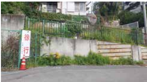
撤去が予定されている コンクリート擁壁
