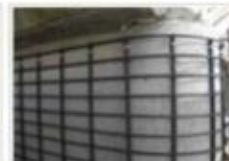
補強鉄筋組立工 (step3)
