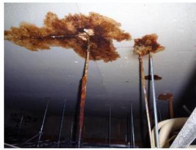
本館：屋根防水等が劣化しているため、2F印刷室では一部天井が腐って落ちている。
