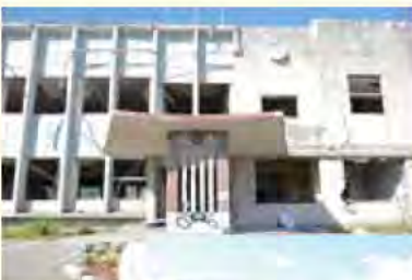
◀津波で全壊した 大槌町役場
