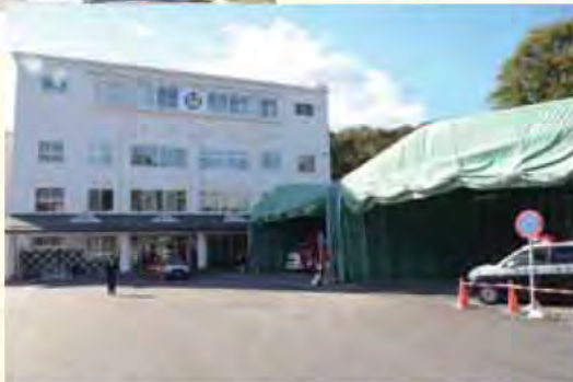
▲大槌町仮庁舎。小学校校舎を改修して使用
