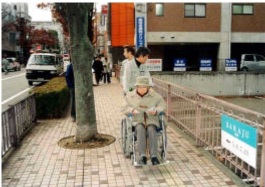
( 歩道上の街路樹が有効幅員を狭めている。)
