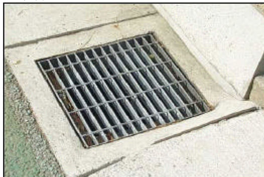
×粗目グレーチング
