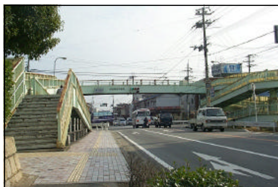
例：市役所前歩道橋
