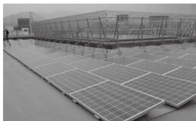
接着剤を用いて屋根の防水や過重に配慮した工法による太陽光パネル(静岡市)
