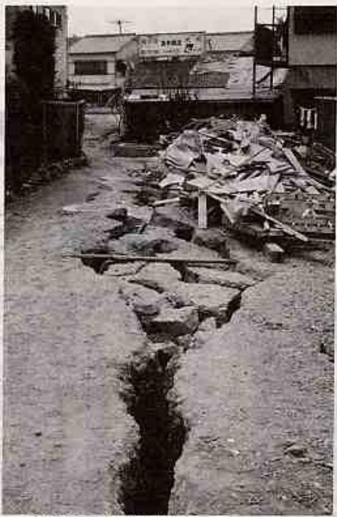
震災復興促進区域に指定した山本東2丁目の被害
