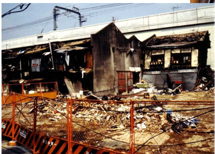
栄町1丁目花のみち周辺の解体作業
