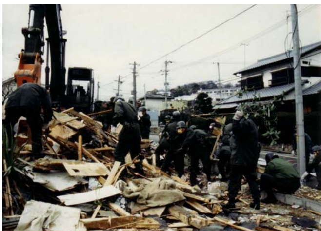
自衛隊による家屋解体 売布2丁目
