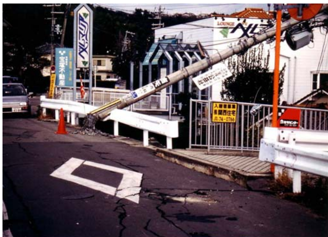
倒れた電柱 売布4丁目
