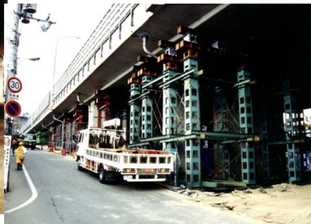
壊れた中国自動車道の橋脚と復旧工事 売布3丁目
