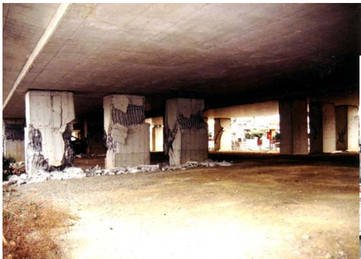
壊れた中国自動車道の橋脚と復旧工事 売布3丁目
