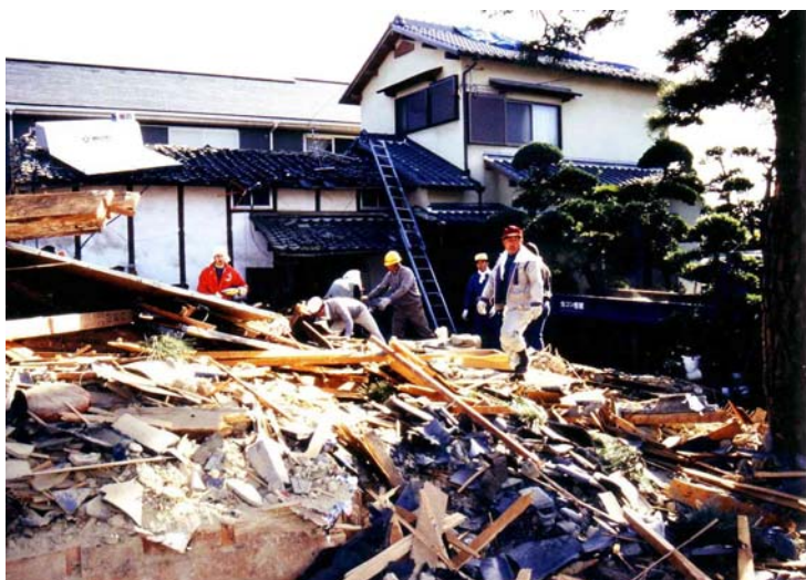
大きな被害を受け解体される長尾中学校の校舎 長尾町
