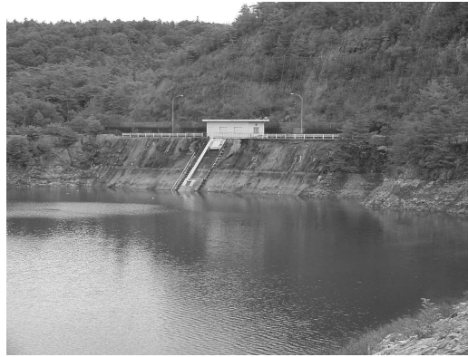
川下川貯水池取水口
