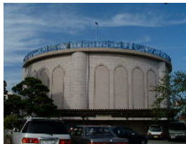
（配水施設の管理）
