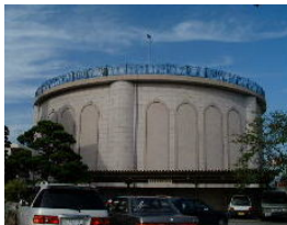
（配水施設の管理）
