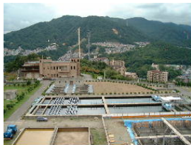
（浄水場の運転管理）
