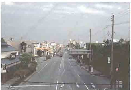
国道176号線東方向道路景観 宝塚市の基幹道路 <301> (6-25)
