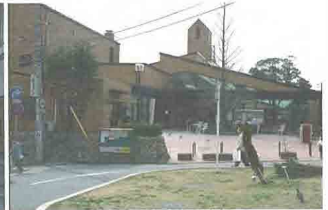
阪急清荒神駅前の ベガホール・中央図書館 38-34 (303)
