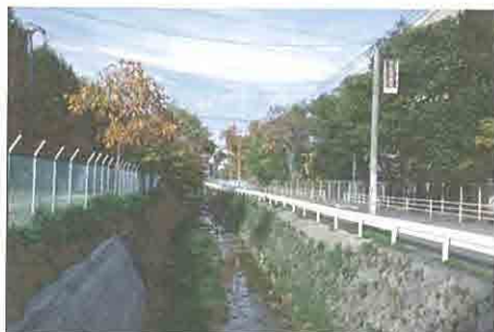
小仁川を上流へ 快適な居住地ルート <102> (26-27)
