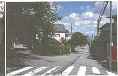
武庫山 傾斜地はまち場内外路網に 三叉路や五叉路を造る <207> (58-13)
