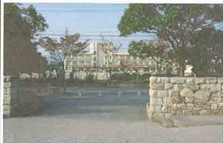
安倉中 安倉下池まわり 下の池公園から安倉小学校 <405> (84-6)
