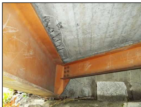
床版に剥離・鉄筋露出が見られます
