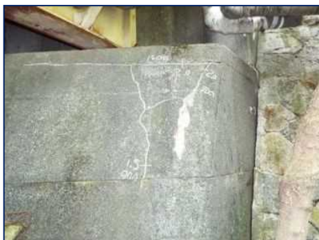
下部工にひびわれが見られます
