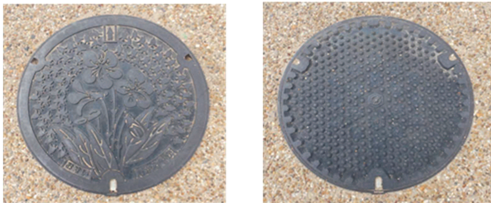
図 3-Ⅱ-Ⅰ マンホール蓋（左：デザイン型、右：ノンスリップ型）
