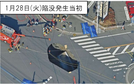
埼玉県の陥没事故の概況
