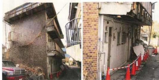
マンションの2階廊下部分が崩落した事例
