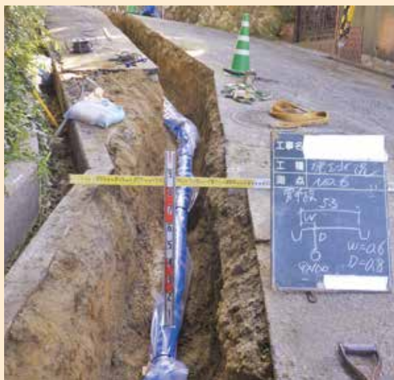
◀水道管更新(耐震化)工事の様子
