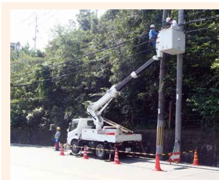
←通信ケーブル張り替え工事の様子
