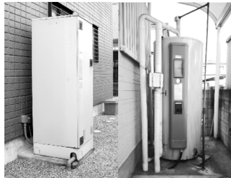
*電気温水器の例
