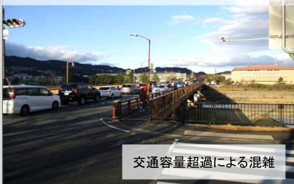
市道逆瀬川米谷線 宝塚新大橋(武庫川渡河部)
