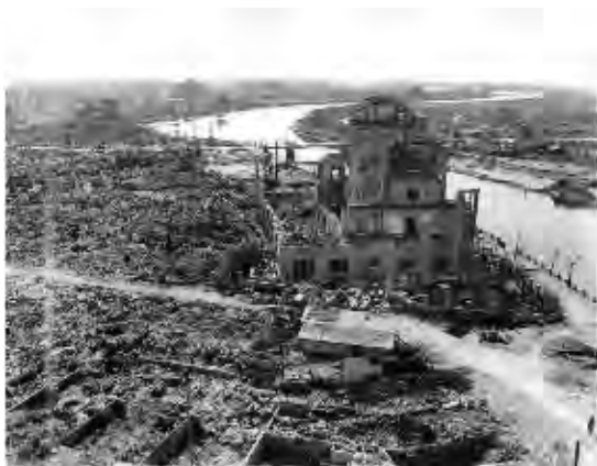
広島産業奨励館（原爆ドーム）と爆心地付近
