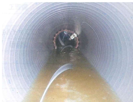
図 3-II-9 管渠の改築状況（巻き出しリングによる製管）
