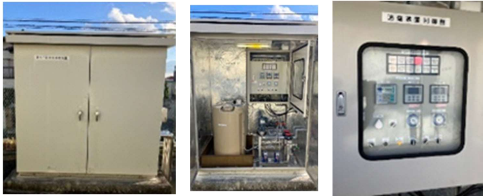
図 3-I-11 追加塩素装置 (左：外観、中：内観、右：計測器)
