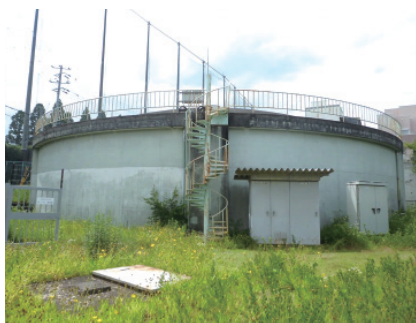
塔の町配水池
