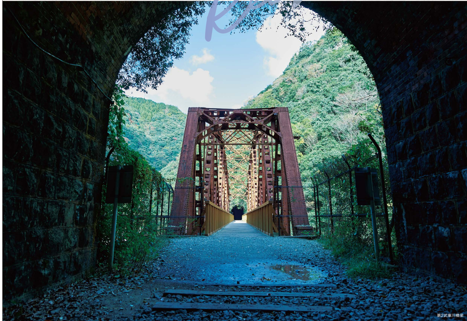
第2武庫川橋梁
