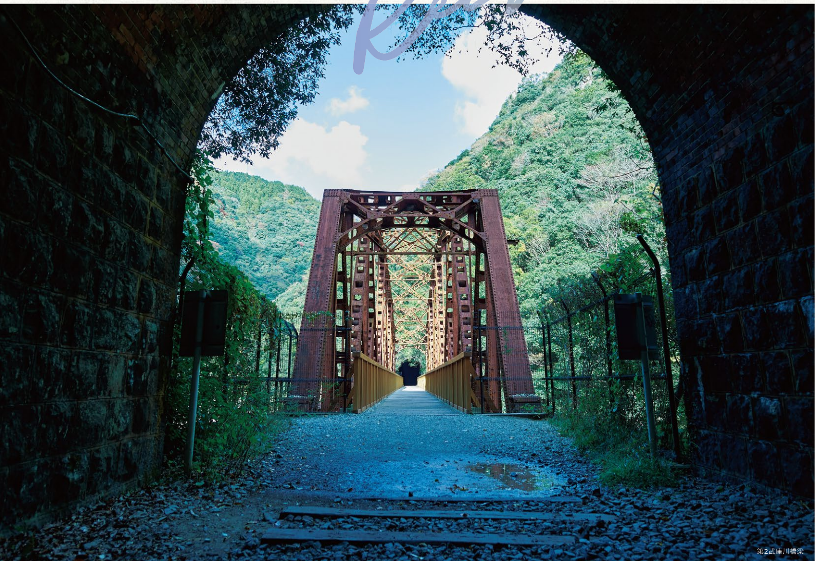
第2武庫川橋梁
